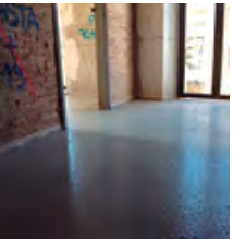
Promsa - Promotora Mediterránea-2, S.A. PROSILENCE es un mortero autonivelante que contiene materiales reciclados que le aportan propiedades termoacústicas superiores a las de otros autonivelantes.
