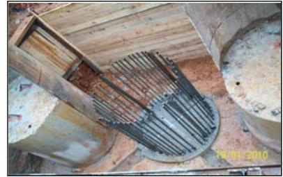
Detalle de pilote descabezado
