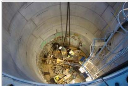
Ejecución de perforaciones para inyecciones
