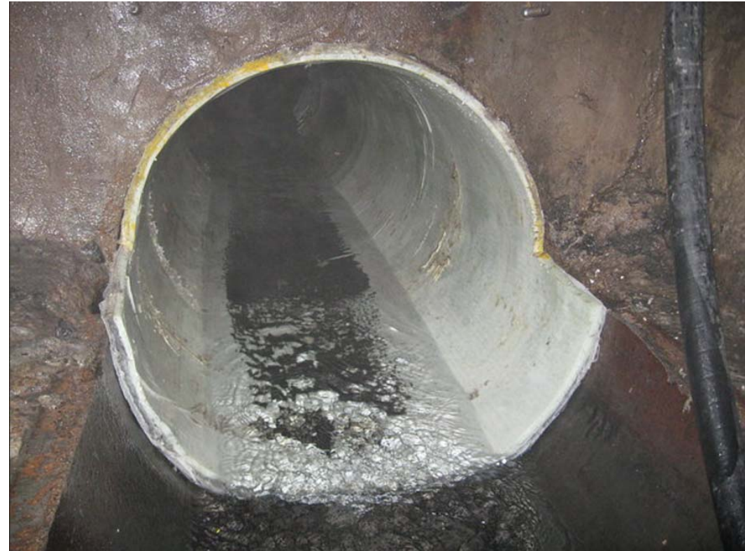
Colector rehabilitado mediante revestimiento interior polimerizado in-situ con radiación UV.
